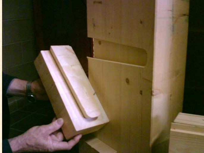
Apoyo de vigueta sobre viga
